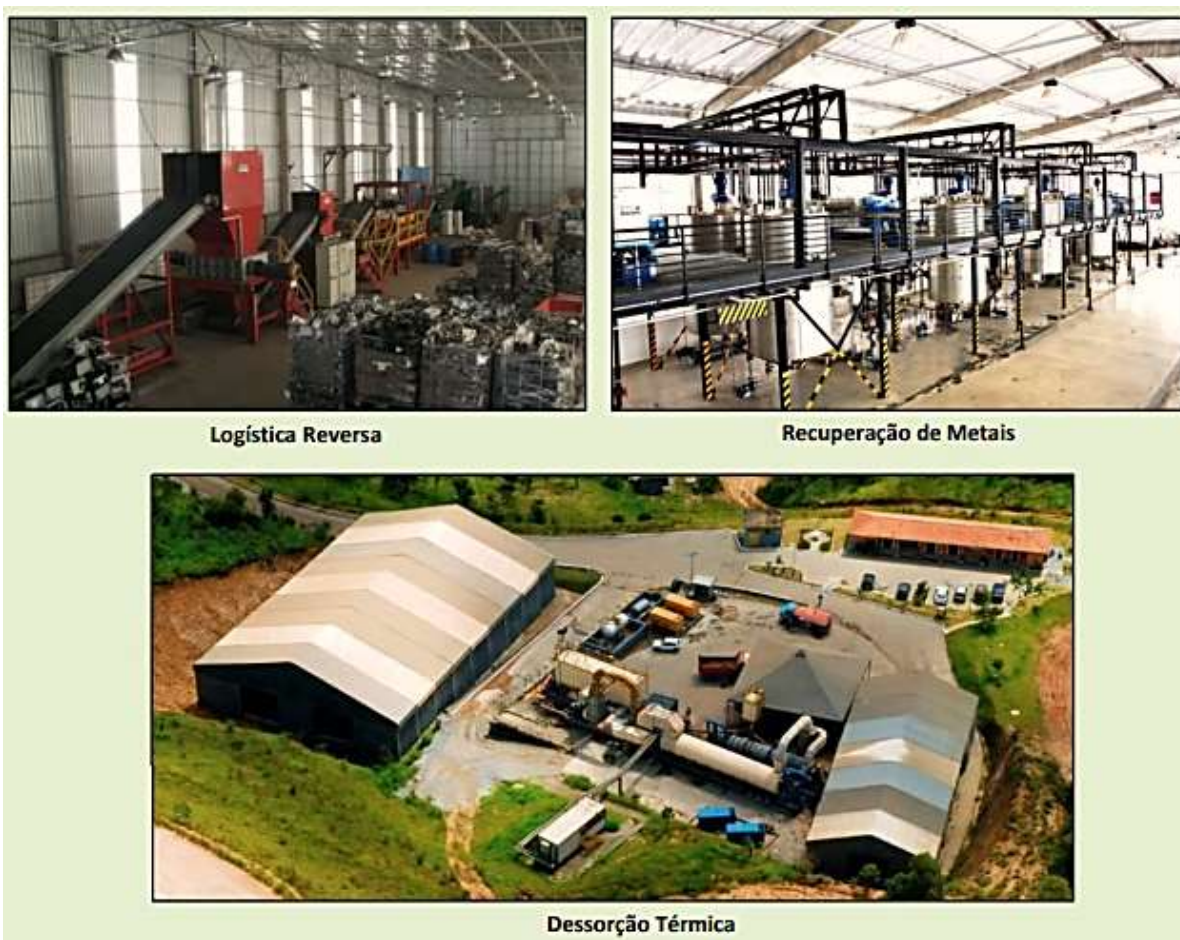
Figura 5 – Unidades de Tratamento da CTVA de Caieiras Fonte: RIMA - Relatório de Impacto Ambiental da CTVA de Caieiras, 2016
