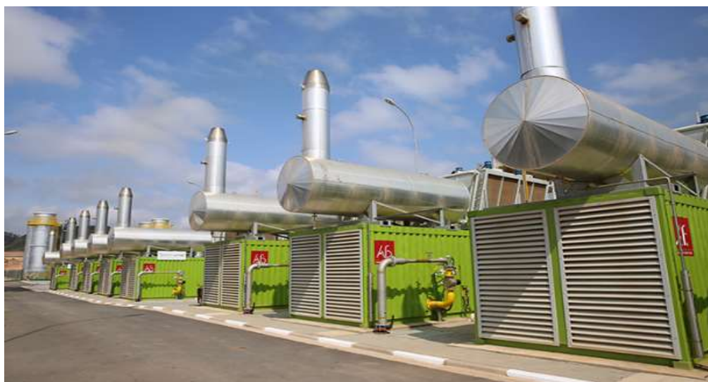
Figura 2 – Usina de Caieiras Fonte: Grupo SOLVÍ
